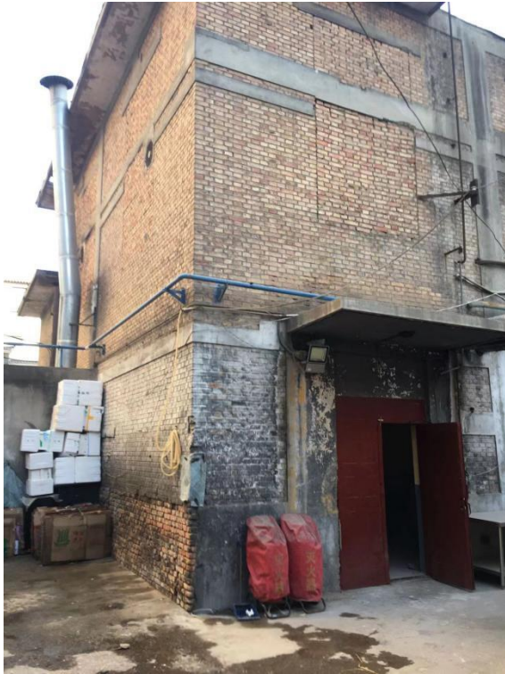
解放商场供热锅炉房现状
