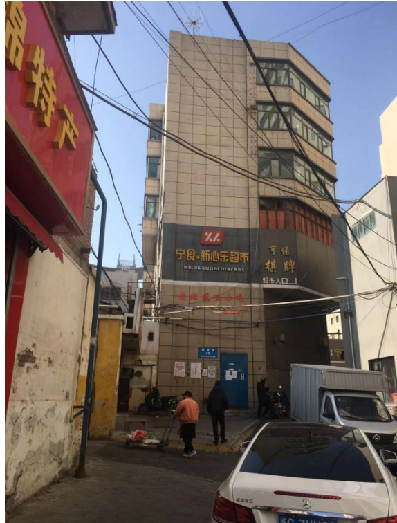
锅炉房北侧为美食城及解放巷道路
