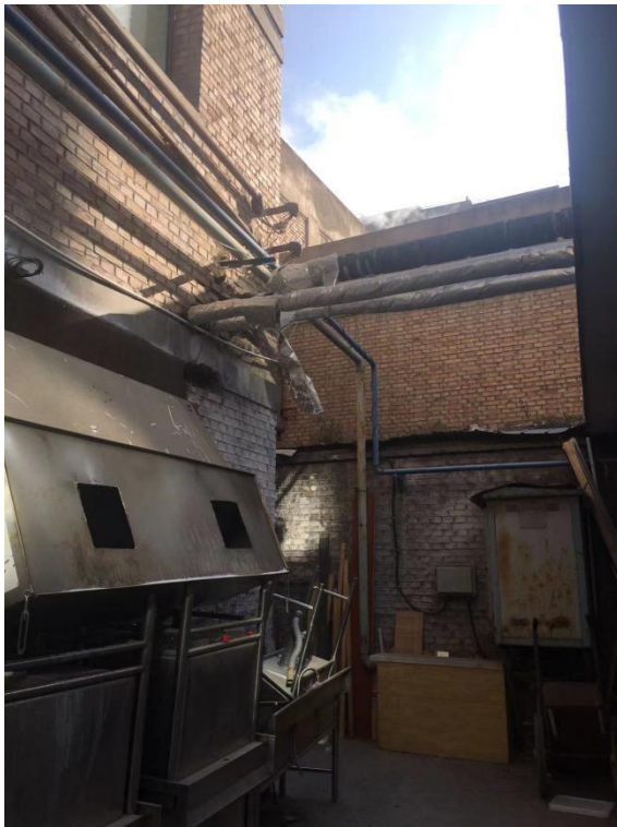
锅炉房南侧为大十字商店锅炉房
